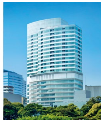
浜離宮インターシティ
